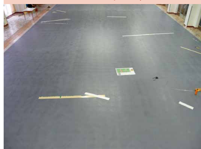
Původní stav podlahy
